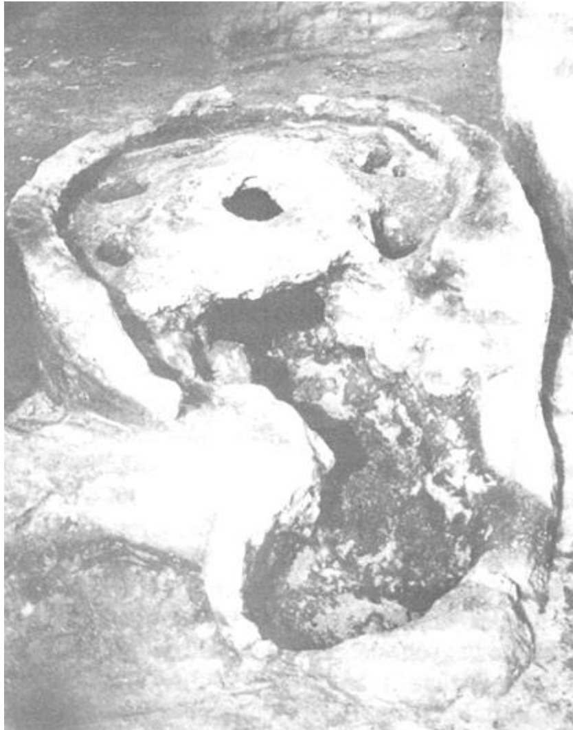
107. Kétrekeszes cserépégető kemence Jarim Tepéből. Alul látszik a tűztér, felső részén légnylások vannak, ide helyezték a kiégetendő edényeket. Boltozata hiányzik. Kr. e. 6. évezred
